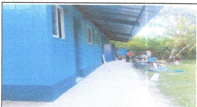
Foto 4: Se observa en la fotografía la rehabilitación del piso rustico de del corredor y pintura exterior.
