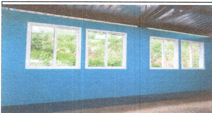
Foto 3: Se observa en la fotografía la instalación final de las ventanas del aula
