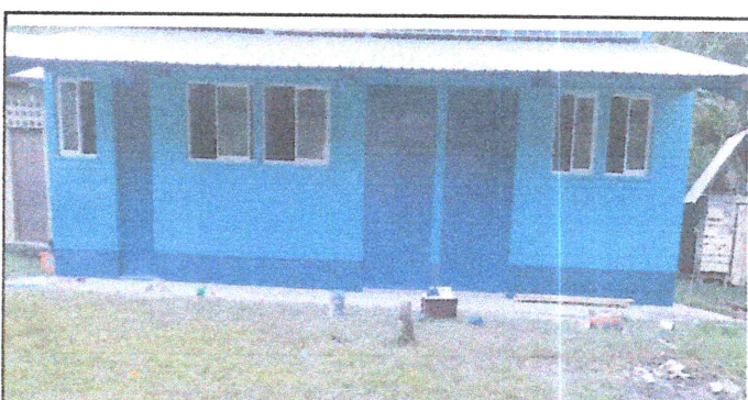
Foto 6: Se observa en la fotografía la repapación y pintada de la puerta de la escuela.
