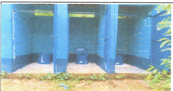
Foto 5: Se observa en la fotografía la instalción final de las tazas, puertas, pintura interior y exterior del baño.
